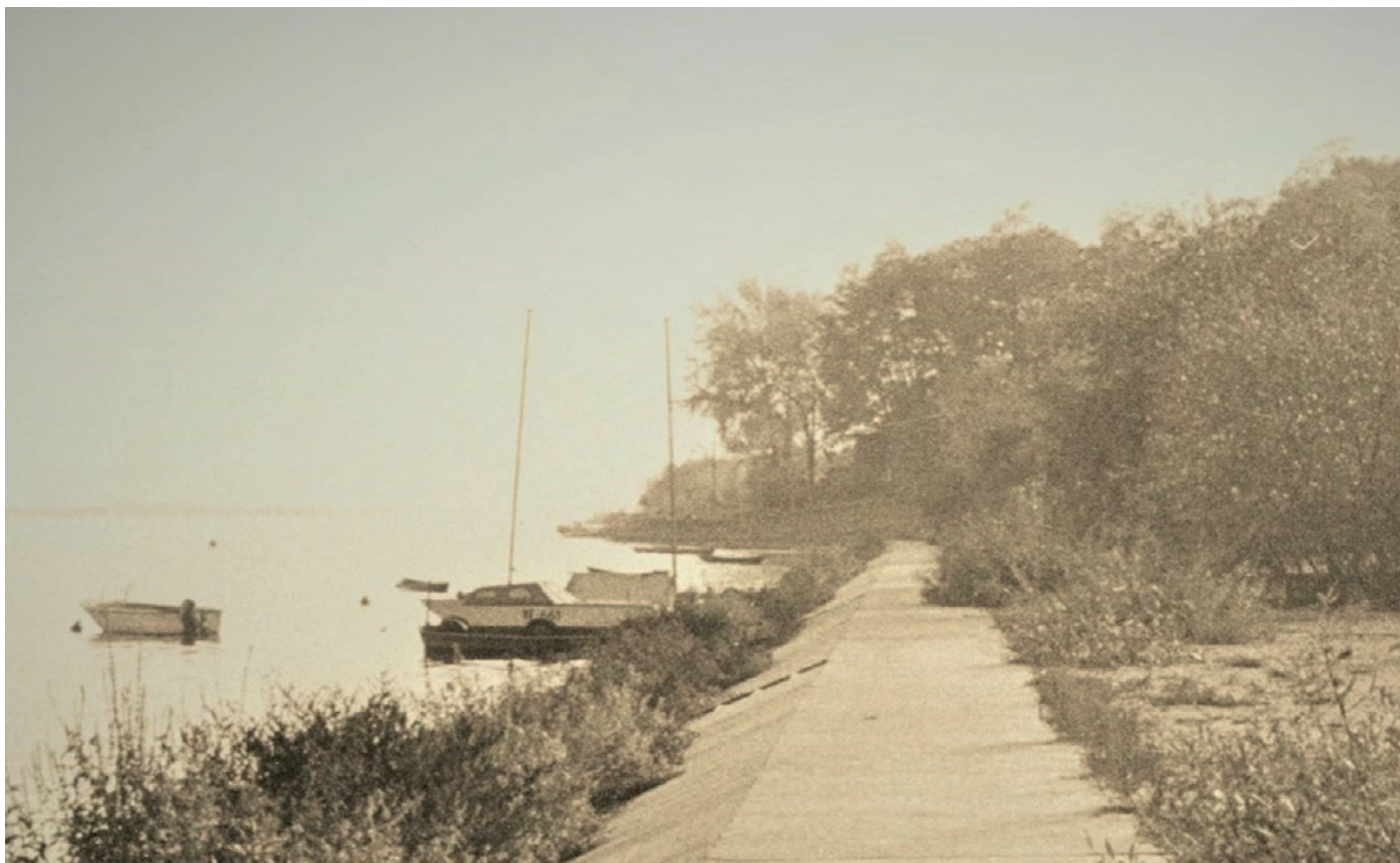
11. Serock. Betonowy bulwar nad rzeką w sąsiedztwie plaży 1977 r. (zbiory Sławomira Jakubczaka)
